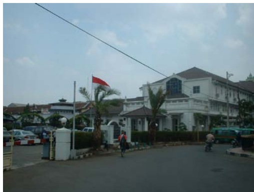
5.3.1.1. Lahan parkir Gedung Administrasi Daop II
