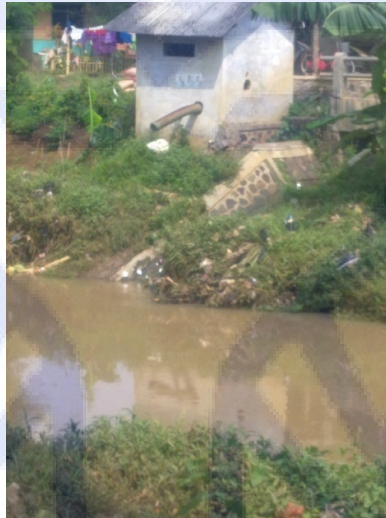
Gambar 2.1 Pipa pembuangan air limbah ke Sungai Citarik di Kecamatan Rancaekek
