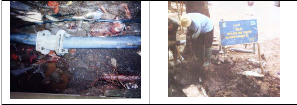
Gambar IV.11 pipa bocor karena akar pohon
