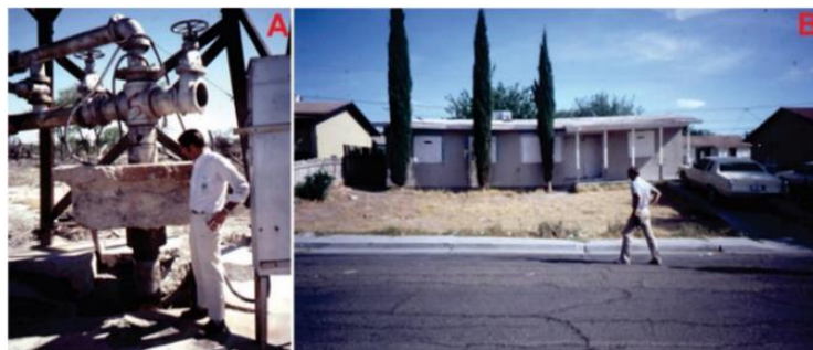
Gambar II. 6 Dampak Land Subsidence di Las Vegas, Nevada, Amerika (Tzampoglou et al., 2023)
