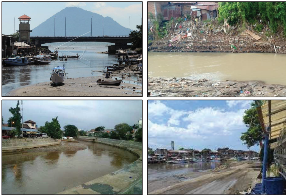
Gambar 1. 1 Kondisi Sedimentasi di Sungai Tondano
