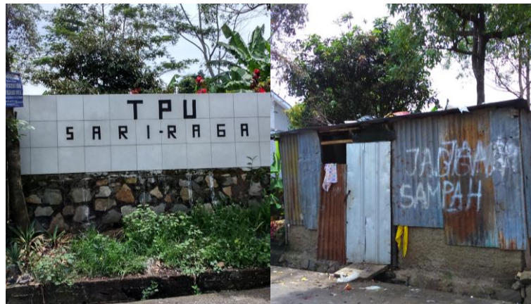
Gambar IV.1 Lokasi dan Bangunan TPS di Desa Sariwangi (Dokumentasi Pribadi, 2016)
