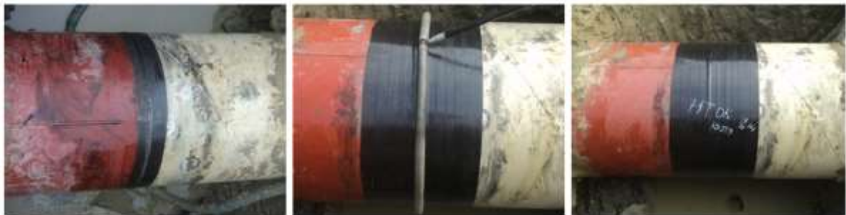
Gambar 4.1 Pipa yang diinspeksi
