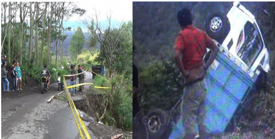
Gambar VError! No text of specified style in document..7 Jalur peralihan truk galian C yang rusak dan dampaknya ( https://www.suaradewata.com , 2017)
