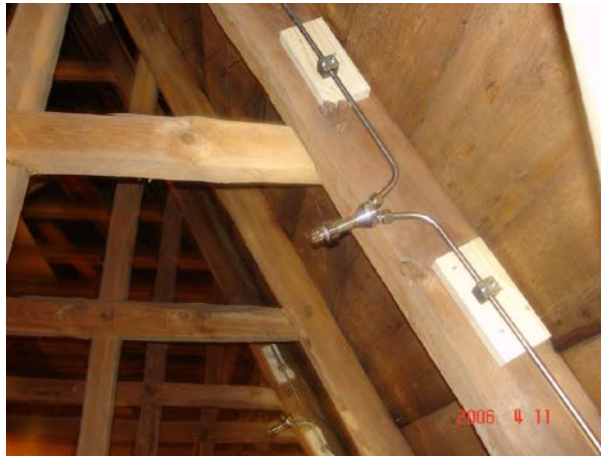
Gambar II.10 Pemasangan nozzle pada atap di Frödinge Church, Swedia Sumber: Arvidson, 2006
